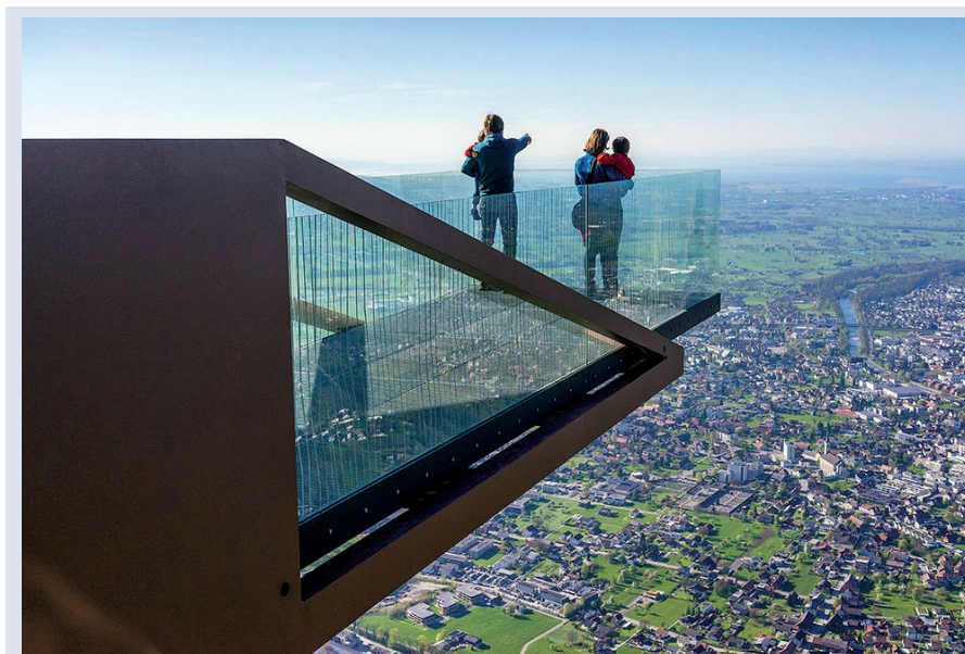
Die Stahlkonstruktion der Aussichtsplattform Karrenkante wird durch meterlange, hochfeste Schweißnähte zusammengehalten.
