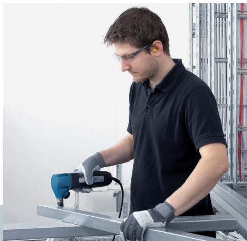
Zuschneiden von Kabeltrassen
